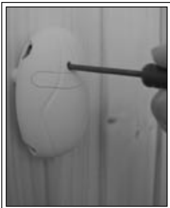
7. ábra: A túlmelegedés-korlátozó Visszaállítás gombja
